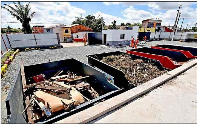
Figura 78: Local de Entrega voluntária de RCD e Volumosos instalado em Ecoponto.
